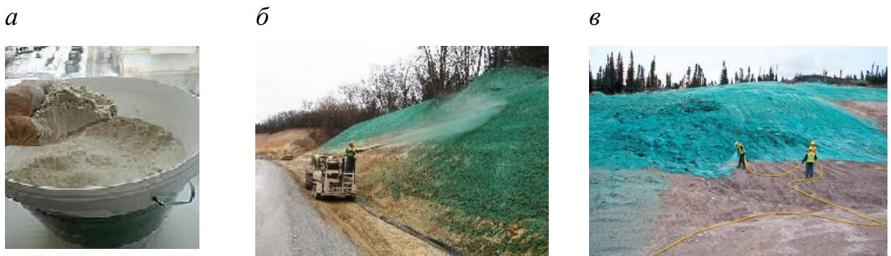
Рисунок 1.6 Технология гидромульчирования перед рекультивацией:
