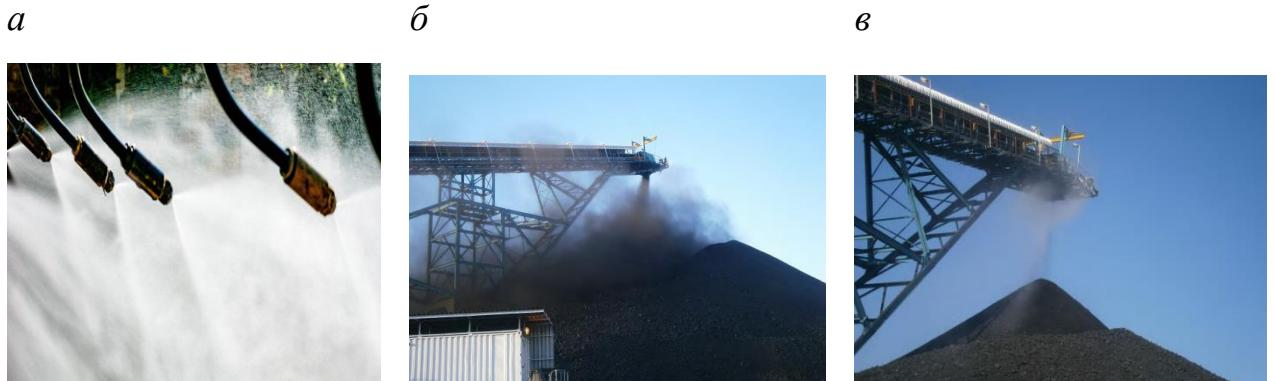
Рисунок 1.4 – Работа пылеулавливающей системы “*Dust-a-Side*” (пенообразователь) на угольном терминале ЮАР, Африка:
