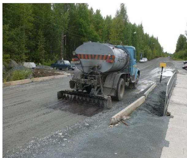
Рисунок 4.7 – Нанесение профилактической эмульсии автогудронатором ДС-39Б
