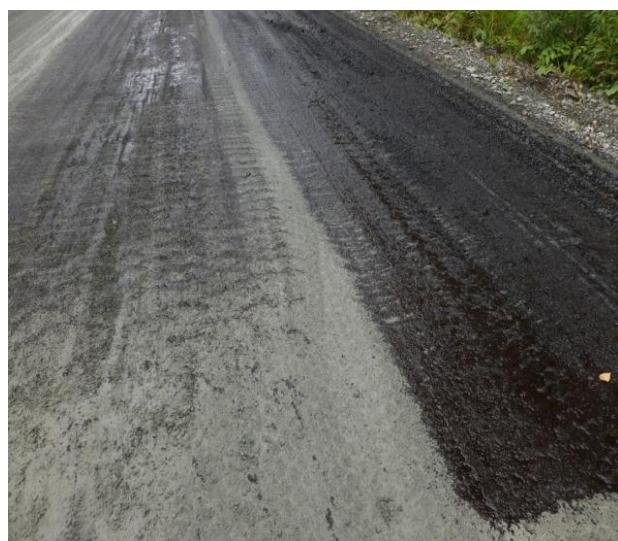
Рисунок 4.8 – Обработка при расходах профилактической эмульсии:
